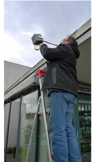
Die Tauben haben die voll verglasten Fensterflächen verschmutzt und waren zu einem Lärm- und Hygieneproblem geworden. Die Problembereiche wurden durch zwei Schalldruckgeräte vor den Tauben geschützt. Die Ornigard Geräte schützen die Fensterflächen, die Dachkanten und die begrünten Flächen vor dem Konferenzraum.
