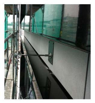
Die Resonatoren sind nur 80 mm im Durchmesser, entspiegelt und von unten so gut wie unsichtbar.
